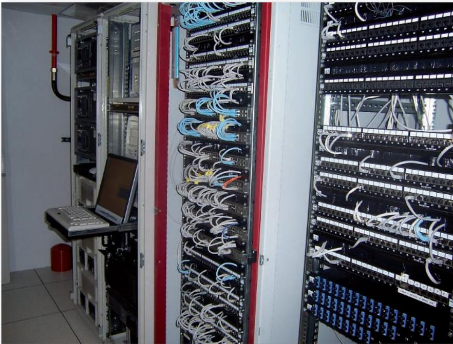
Fig. 2.23. Vista de un cuarto de comunicaciones instalado con cableado estructurado y certificado.
