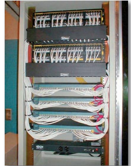
Fig. 2.4. Vistas de un rack para cableado estructurado.
